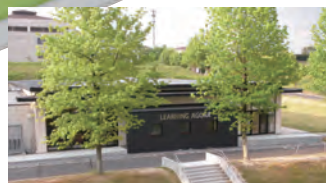
21 ラーニングアゴラ棟
