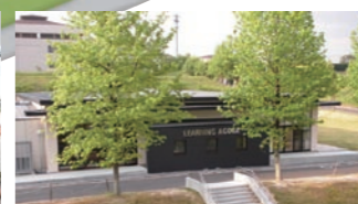
21 ラーニングアゴラ棟
